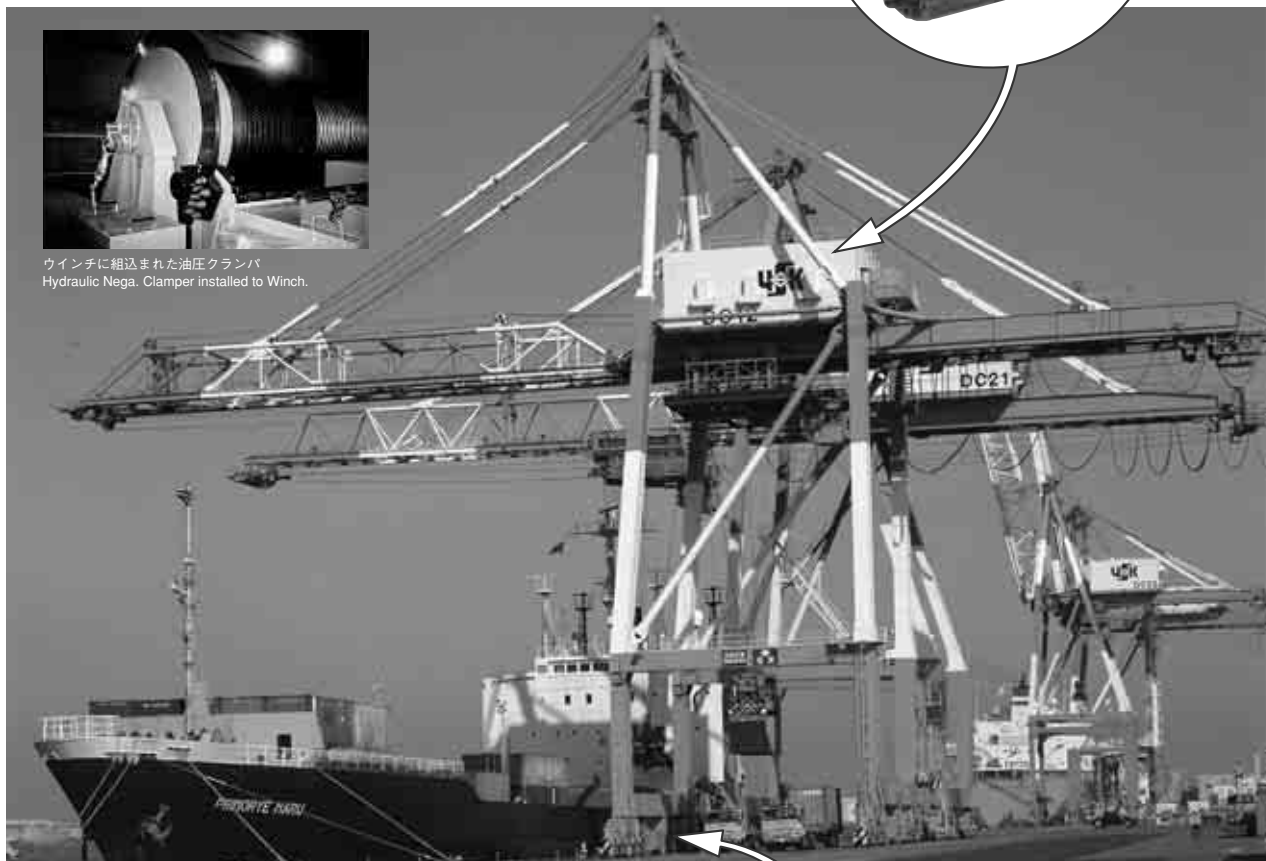
コンテナクレーン CONTAINER CRANE
